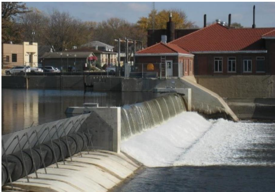
Figur 36: Obermeyer luke. Ved venstre luke kan den oppblåste gummipølsen sees med lukebladet liggende over. Luken til høyre er noe senket slik at vann renner over (foto: Obermeyer Hydro, Inc.)
